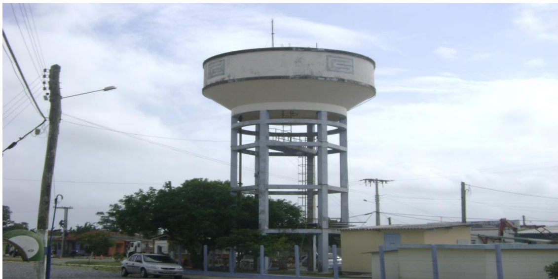
Foto- Estação de tratamento de água central Corsan - Tavares
