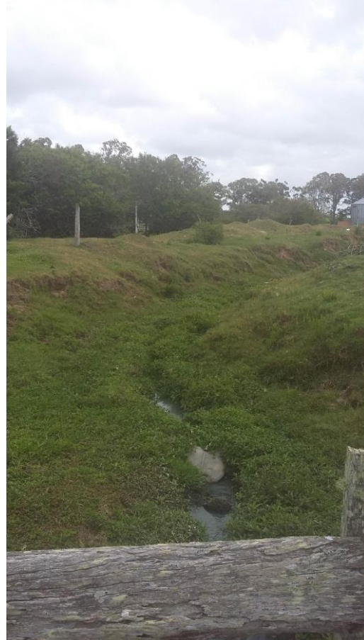
Figura 7-7 – Detalhe do canal que escoar a água captada no sistema de microdrenagem
