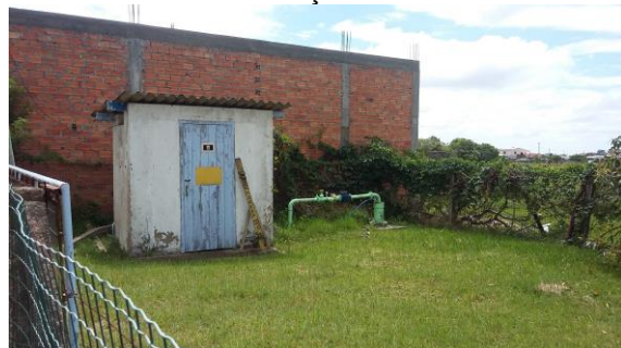
Figura 4-4 - Manancial de captação de água bruta – Poço TAV-02
