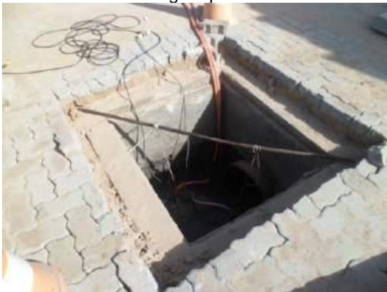
Figura 7-13 - Implantação do sistema de drenagem pluvial
