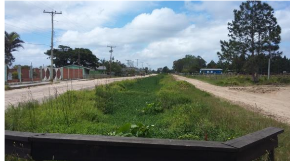
Figura 7-11 – Vista do valo na Avenida Onze de Abril
