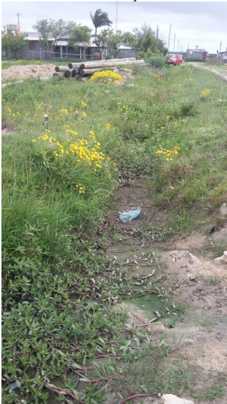
Figura 7-2 – Valo para drenagem pluvial em via não calçada
