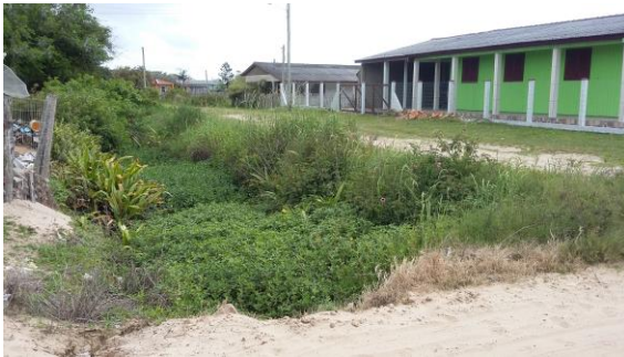
Figura 7-10 – Vista de um dos valos de maior porte responsável por drenar a parte leste da zona urbana
