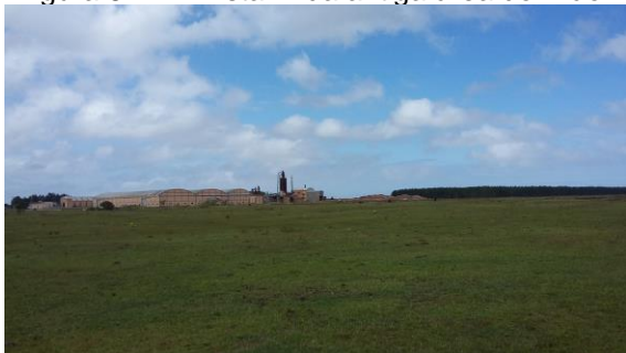
Figura 6-21 – Vista III da antiga área do lixão
